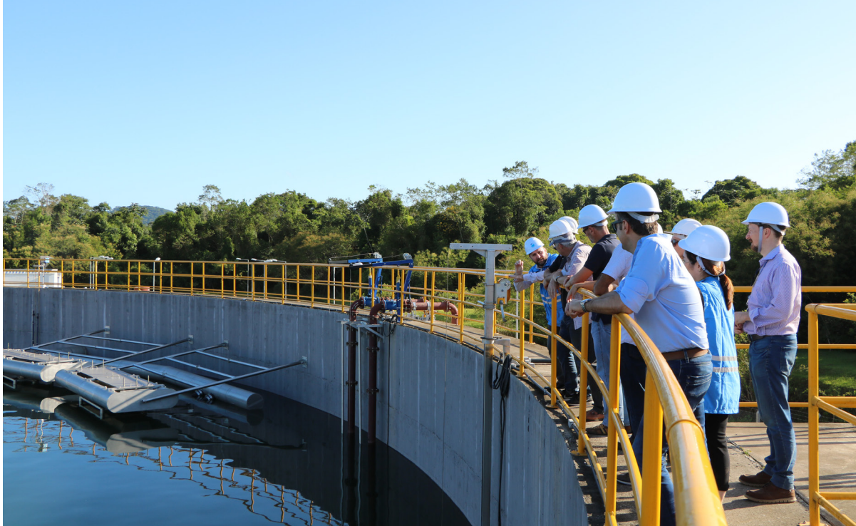
Visita de gestores e membros do Conselho de Administração às obras da ETE Jarivatuba
