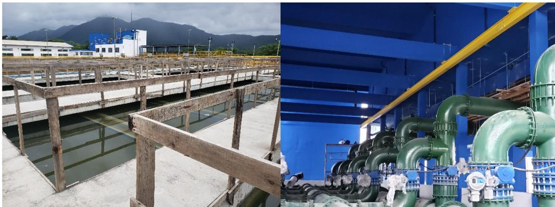
Barrilete de descarga da água de lavagem dos filtros e decantador em teste de carga
