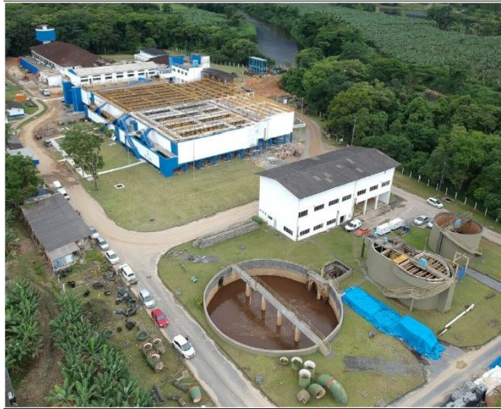
Foto 1: Ampliação da ETA Cubatão (crédito imagem: Bruno Gentil)
