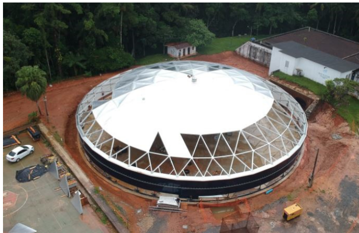
Foto 2 - Ampliação Reservatório R0 (Crédito imagem: Bruno Gentil)
