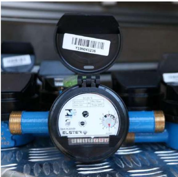
Modelo A de hidrômetro usado pela Companhia
