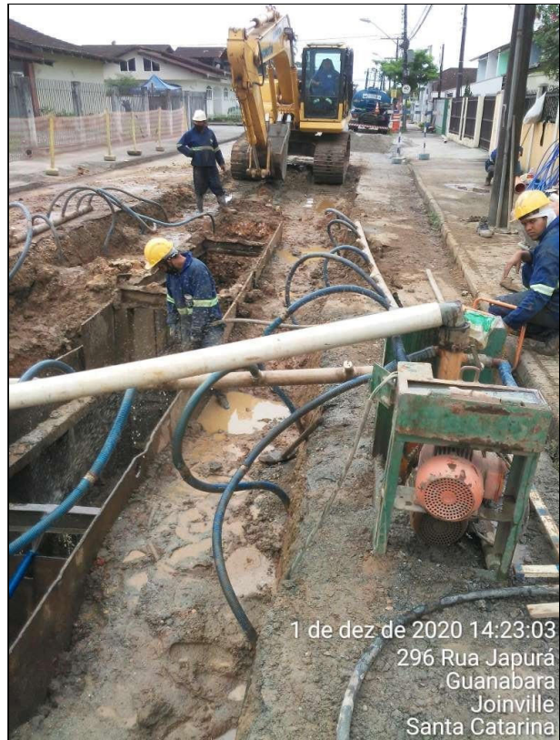
Figuras 17 e 18: Obras de esgoto da 3ª etapa (pacote 4) das Bacias 8.1 e 9 (12/2020)
