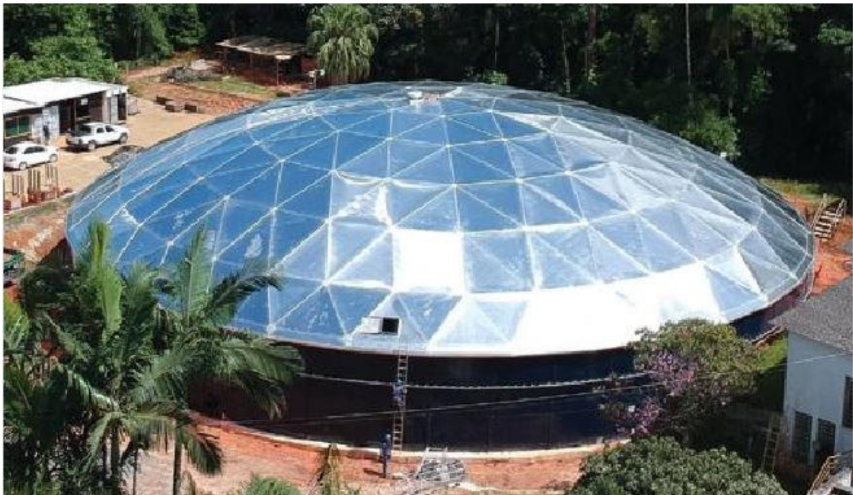
Figura 11: Obra ampliação do Reservatório RO finalizada em 04/2020 (12/2020)
