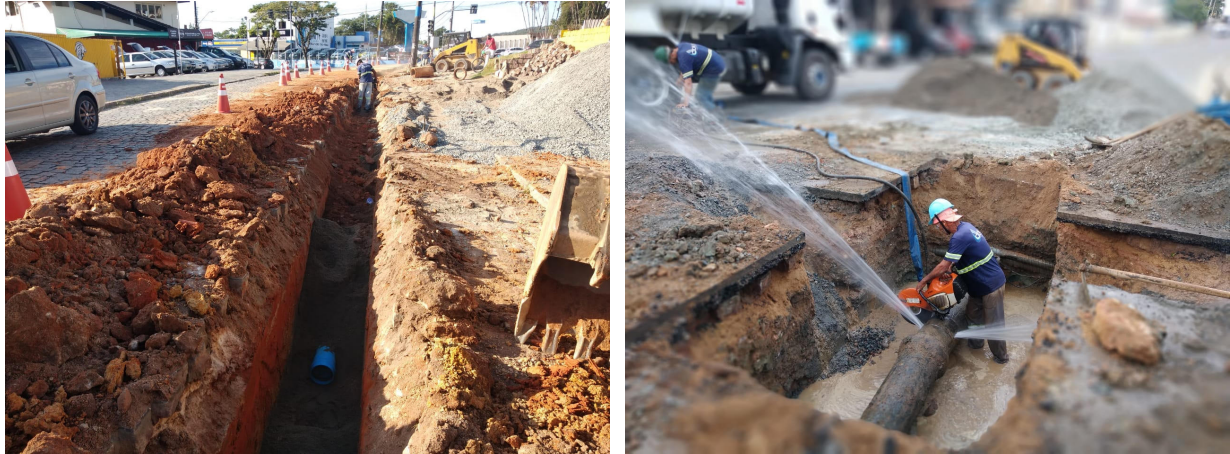
Figura 9 e 10: Obras de água do Pacote 2 (06/2020)
