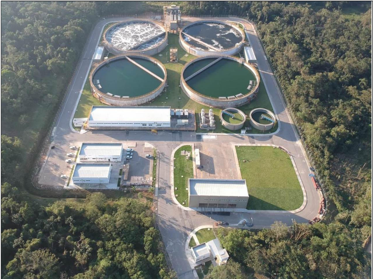
Figura 15: Obra Nova ETE Jarivatuba em estágio de pré-operação (12/2020) Fonte: CAJ.DITEC.GEX / Crédito imagem aérea: Bruno Gentil
