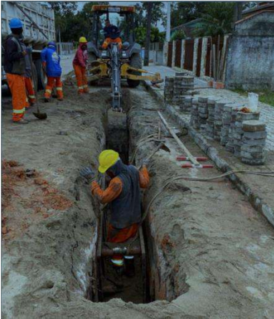
Foto 4 – Exemplo de Implantação de Rede de Esgotamento
