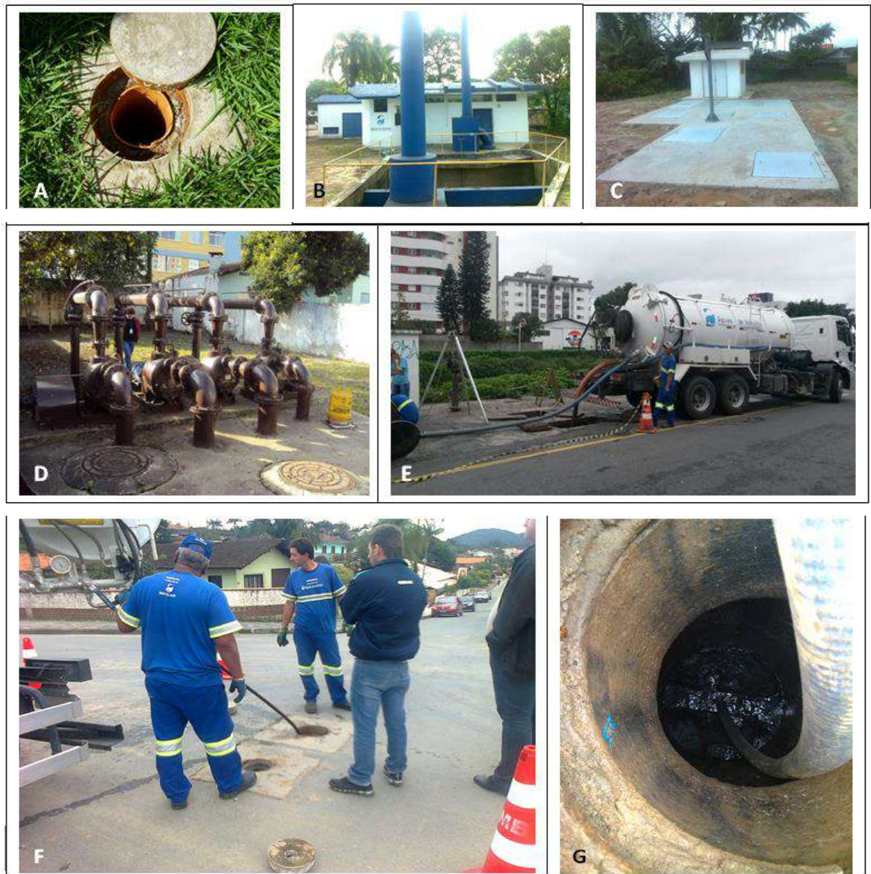
Figura 5. SES Joinville: A) Caixa de Inspeção da Ligação de Esgoto; B) ER-Centro; C) ER – D5 Nova Brasília; D) ER-Miguel Couto; E) Limpeza Gradeamento ER-Angeloni; F) Desobstrução de Rede – Nova Brasília; G) Poço de Visita.
