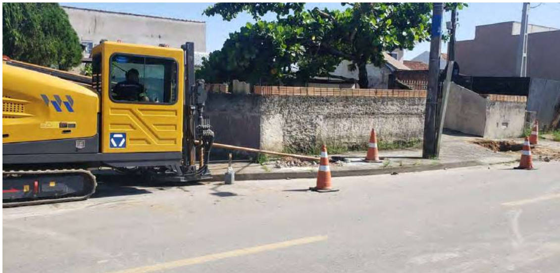
Foto 5 – Exemplo de Implantação de Rede de Esgotamento através de MND – Poço de Lançamento em Calçada
