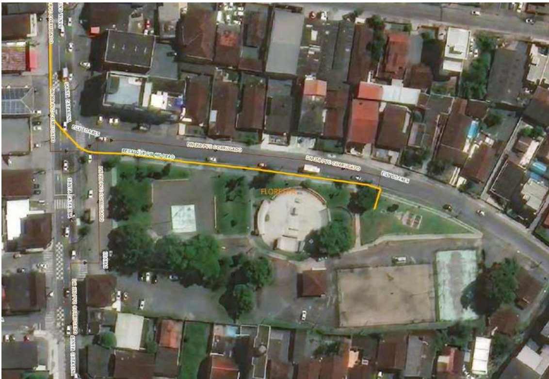
Figura 6 - Estação Elevatória de Grande Porte – Bacia 7-32
