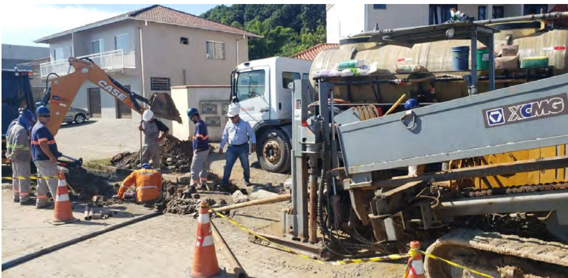
Foto 4 – Exemplo de Implantação de Rede de Esgotamento através de MND – Poço de Lançamento no Sistema Viário.
