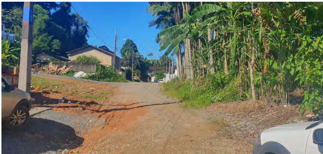
Foto 14 – Bacia 7 – Vista de acesso não pavimentado onde haverá implantação de rede com vegetação em terrenos lindeiros
