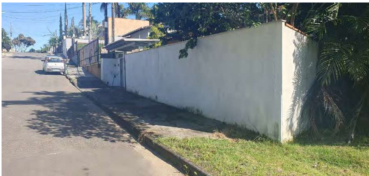
Foto 36 – Muro de residência onde poderá ser implantado o painel de controle da EE11.
