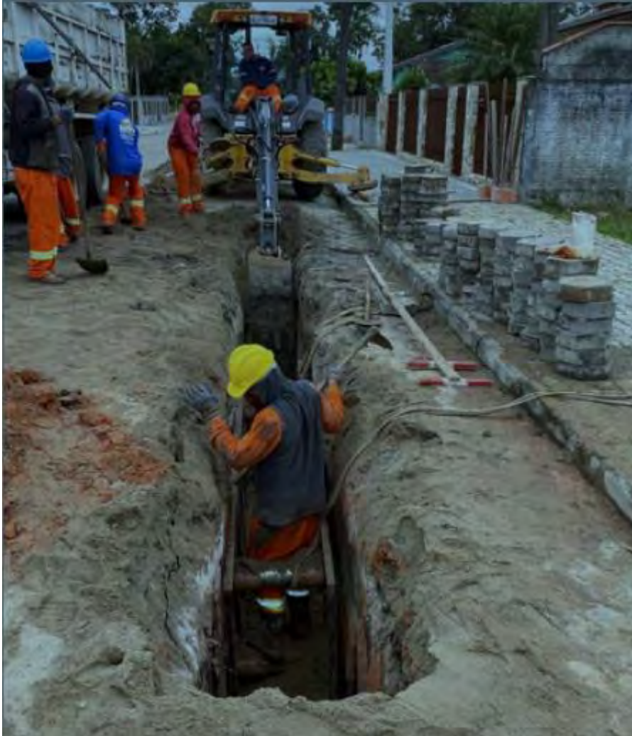
Foto 3 – Exemplo de Implantação de Rede de Esgotamento com abertura de vala
