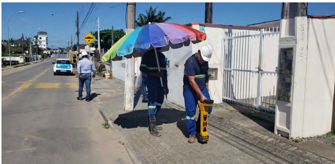
Foto 6 – Navegador na superfície monitorando a trajetória do Furo Direcional
