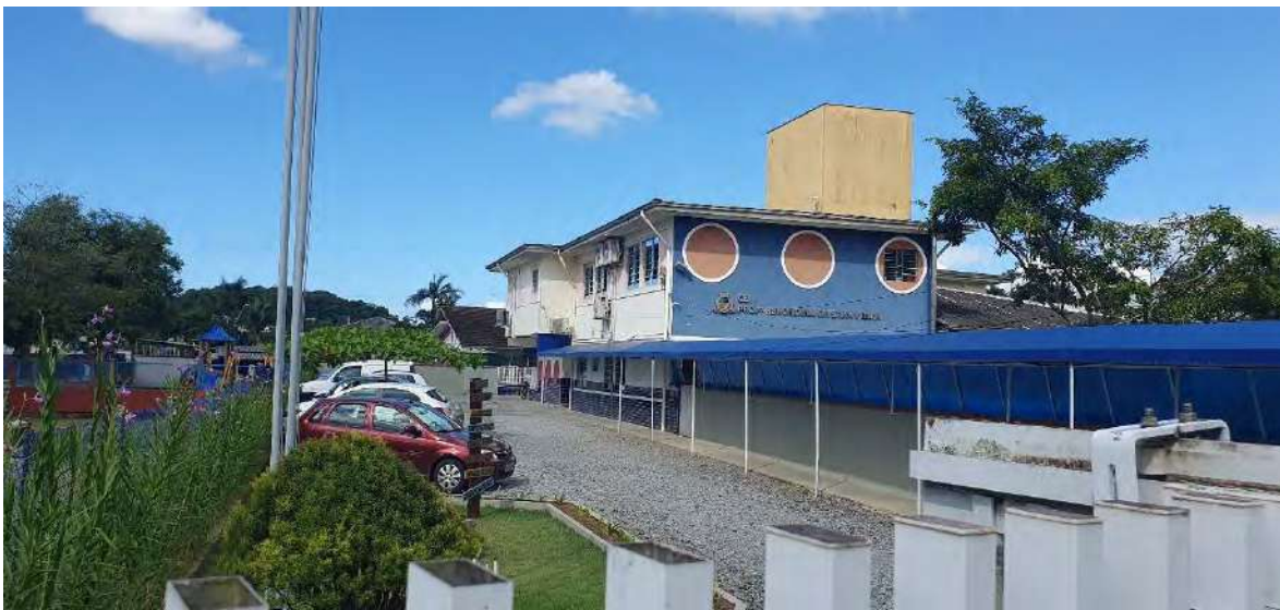
Foto 43 – Vista interna do estacionamento do CEI por onde passará a SUB15 subterrânea
