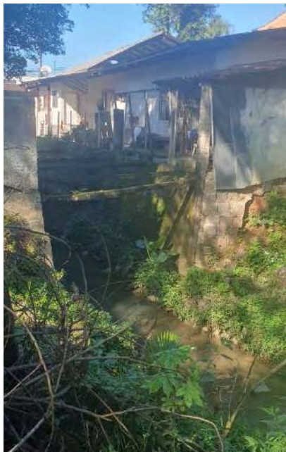
Foto 34 – Vista do córrego e das residências avançando no leito do rio e com descarga de efluentes domésticos diretamente no corpo hídrico.
