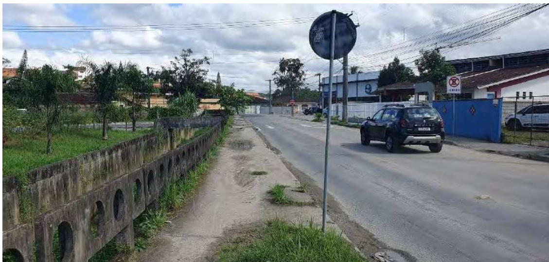
Foto 13 – Bacia 7 – Vista de viário onde haverá implantação de rede com córrego paralelo à via
