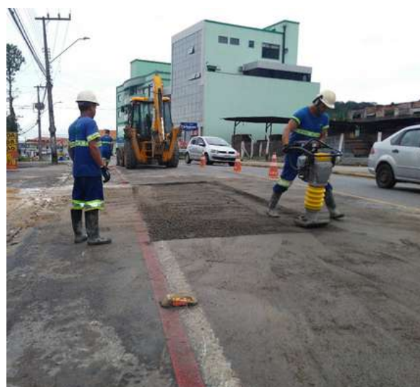
Compactação mecânica (Equipamento a Percussão Tipo Sapó)
