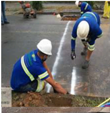
Execução do corte no pavimento asfáltico
