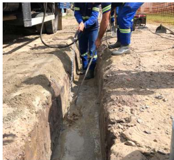
Execução do adensamento hidráulico
