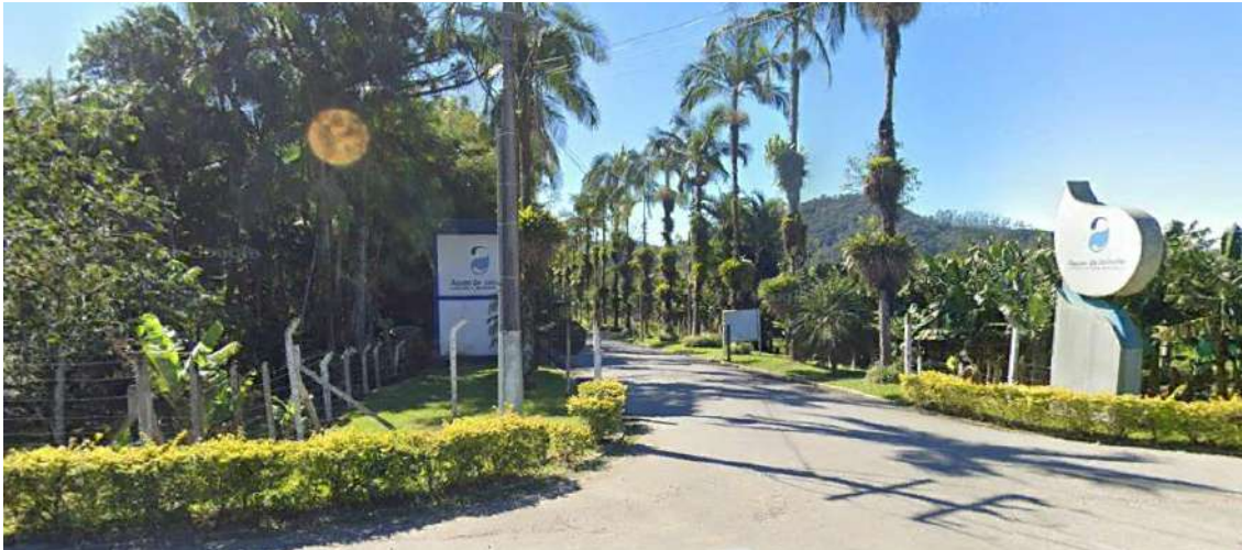
Foto 22 – Vista da entrada da ETA Cubatão
