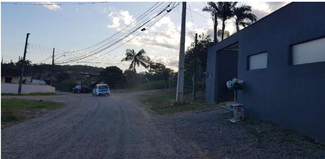
Foto 5 Arruamento sem Pavimento onde será implantada a Adutora – Rua Cidade de Surubim
