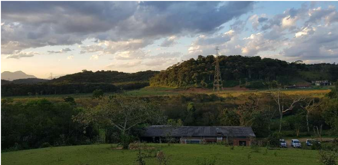
Foto 24 – Morro onde será instalada a ETA Pirai Sul – Após Terraplenagem
