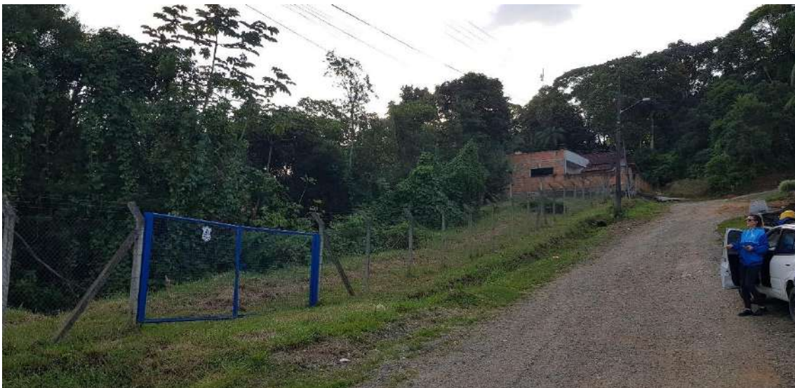
Foto 9 – Local onde será instalado o Reservatório R9
