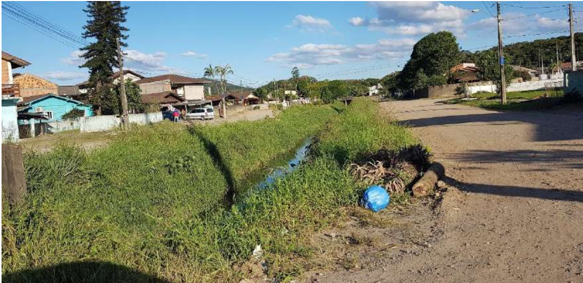
Foto 8 – Ponto de Travessia do Rio Itaum
