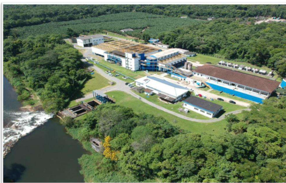
Figura 1. Estação de Tratamento de Água do Rio Cubatão.
