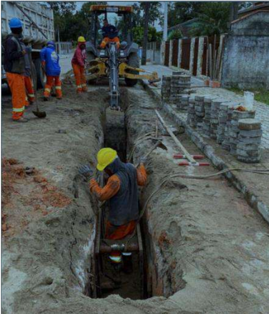
Foto 4 – Exemplo de Implantação de Rede de Esgotamento
