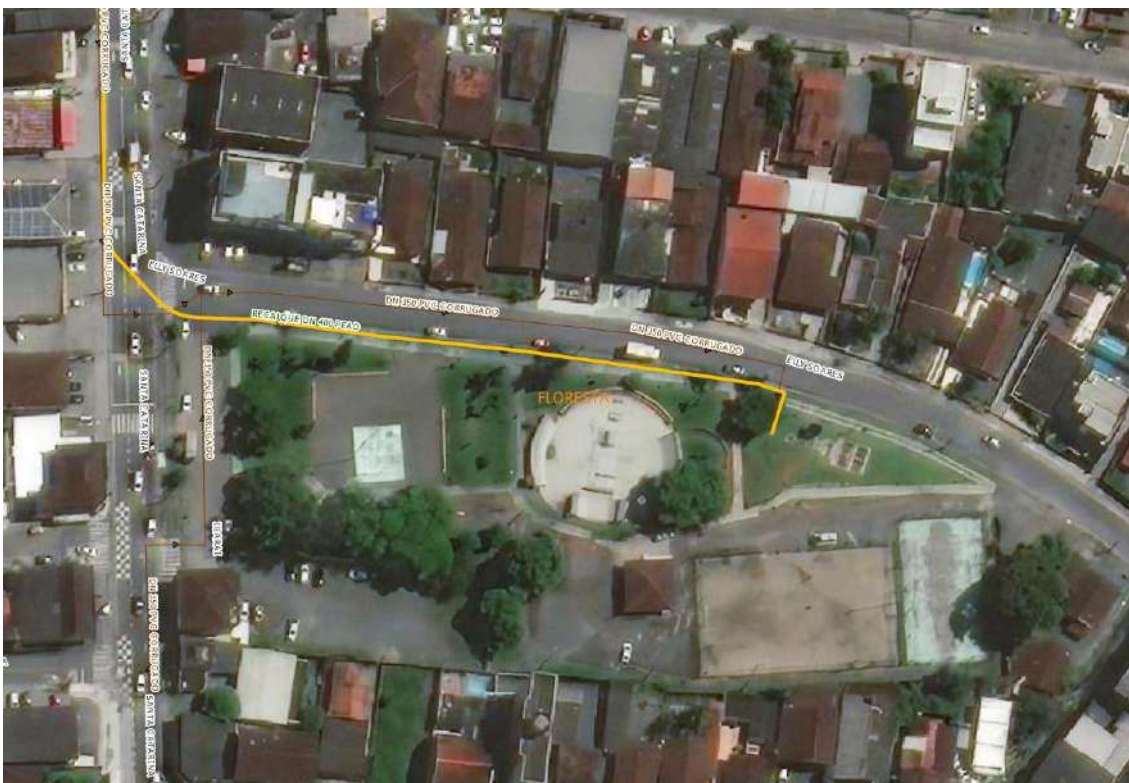
Figura 6 - Estação Elevatória de Grande Porte – Bacia 7-32
