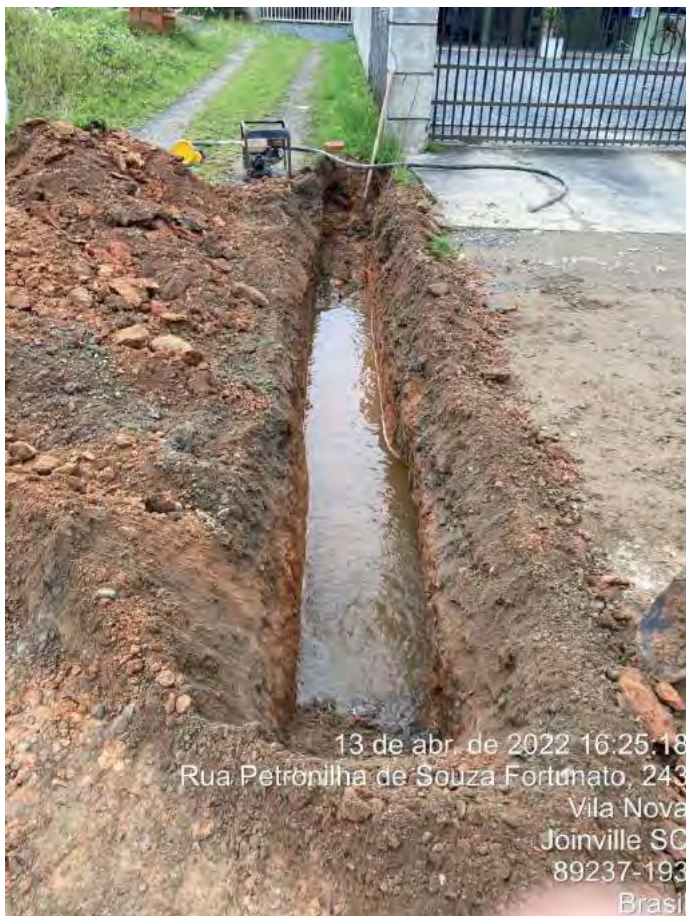
Foto 9 – Vala aberta para reforma da rede coletora
