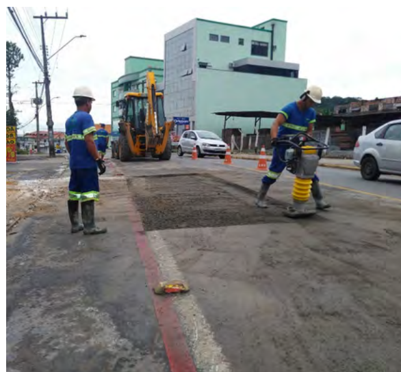
Compactação mecânica (Equipamento a Percussão Tipo Sapó)
