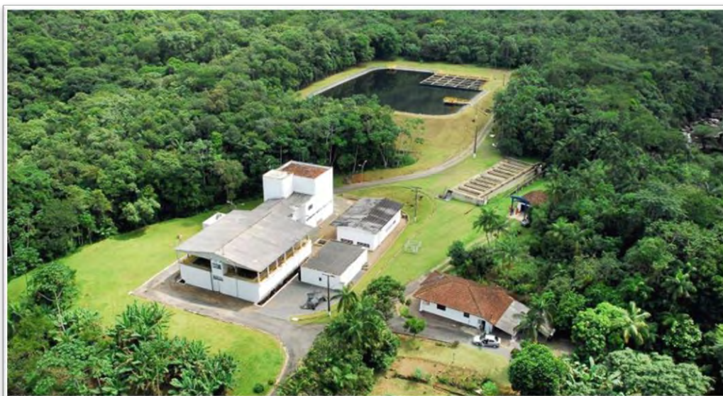
Figura 2. Estação de Tratamento de Água do Rio Pirai.
