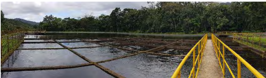
Foto 3 – Tratamento (floculação e decantação)
