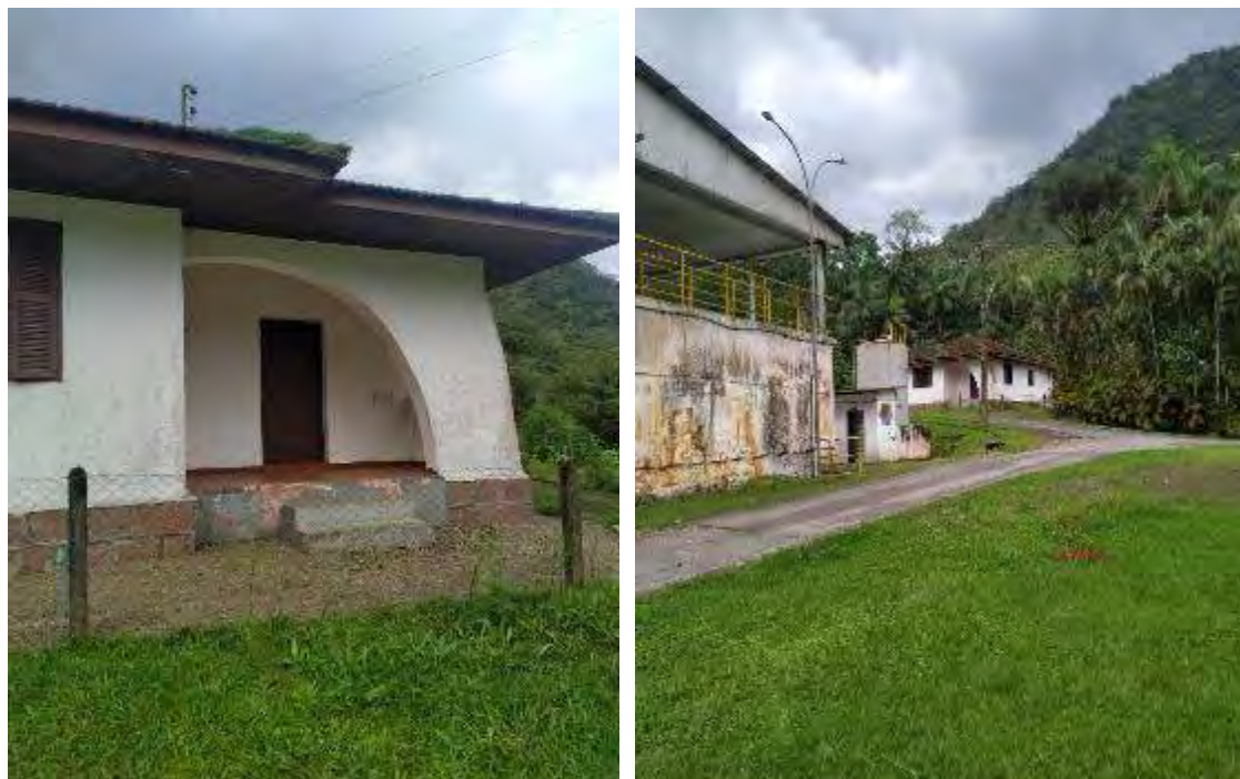
Foto 44 – Vistas da casa de alvenaria – ETA Pirai
