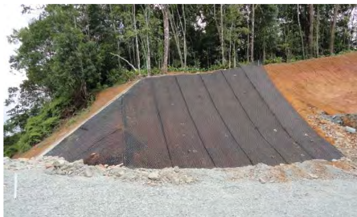
Figura 20 – Geotêxteis instaladas em talude. Fonte: CAJ, 2011
