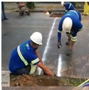
Execução do corte no pavimento asfáltico
