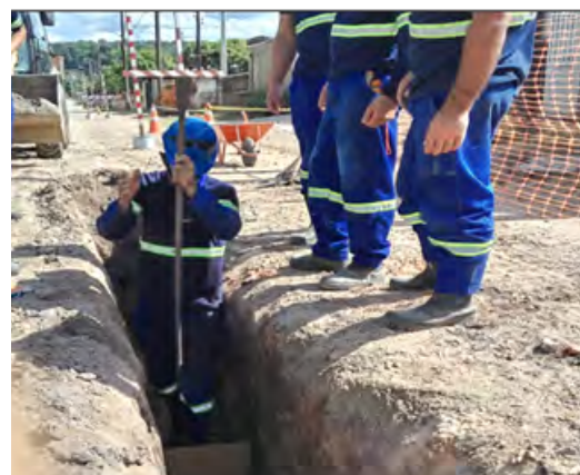
Execução do assentamento e posicionamento do tubo junto à bolsa com tábua de proteção e alavanca
