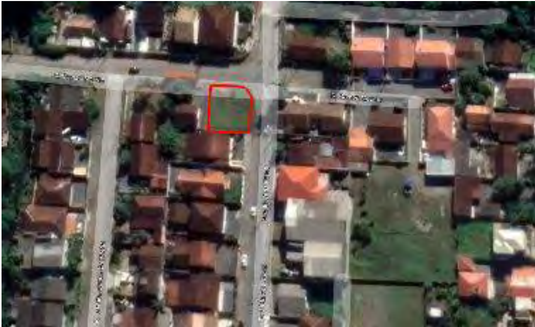
Figura 85 - Terreno Rua Aída Ana Eccel, esquina com Campo Mourão – Bacia 8.2 – etapa 1
