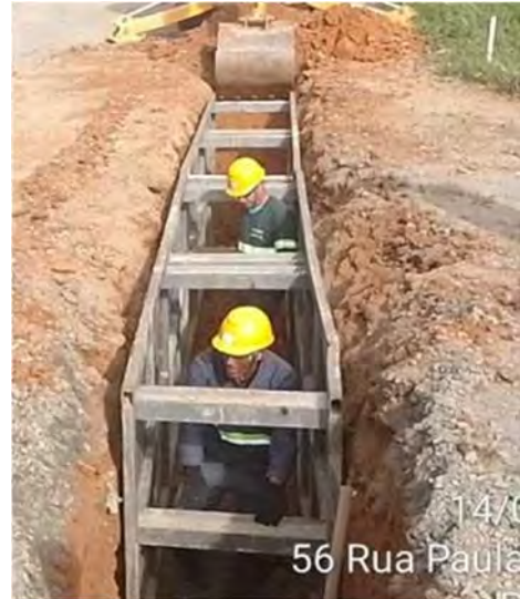
Figura 13 – Escoramento Contínuo (Fonte: CAJ)
