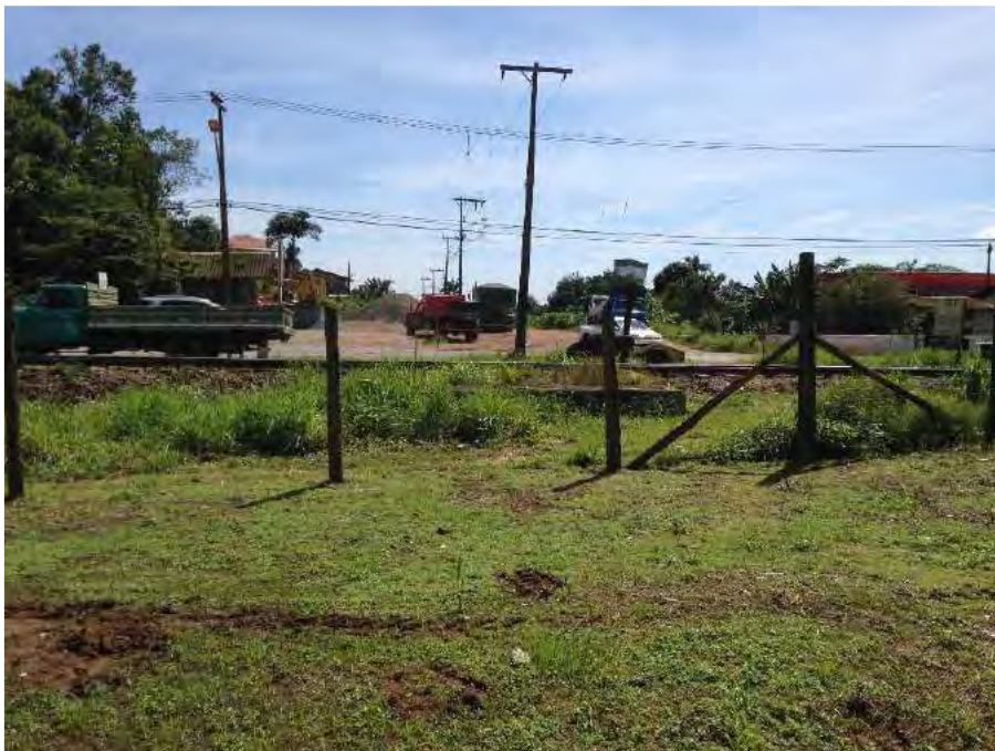
Foto 17 – Ponto de Travessia sob Ferrovia
