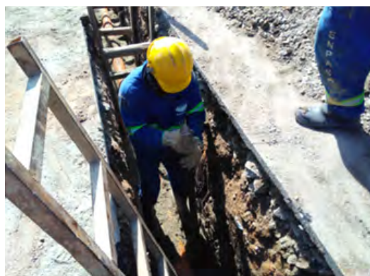
Execução de apiloamento da areia com soquete nas laterais da tubulação
