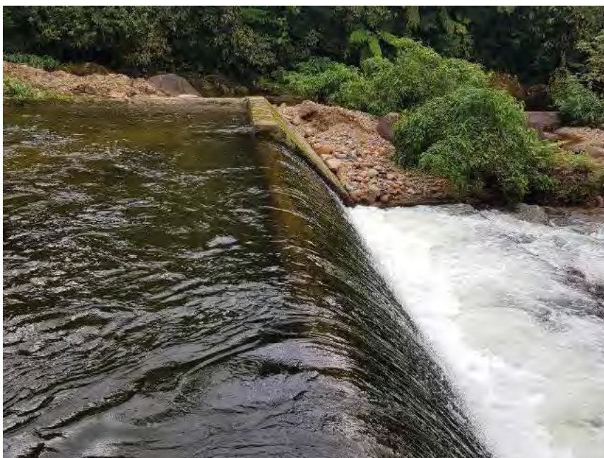
Foto 2 – Barramento da Captação antiga
