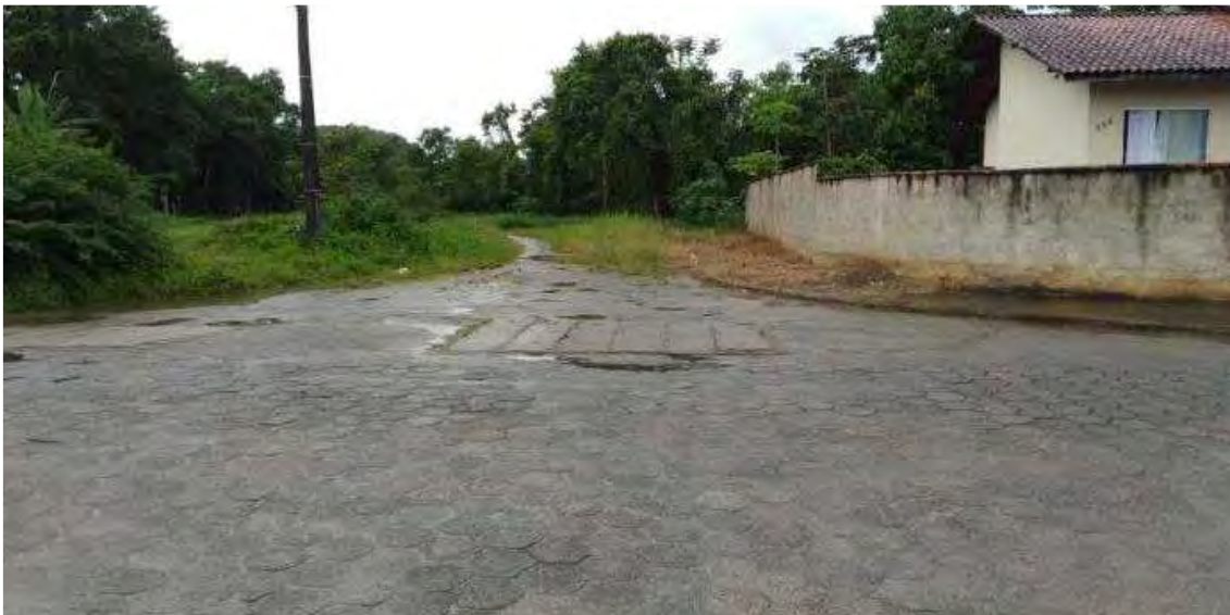
Foto 49 – Vista da entrada do terreno da Rua Laranjal (Bacia 9 – etapa 3) – pela Rua Antidio Paulo Gesser, próximo ao nº220
