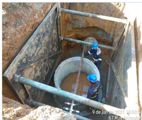
Figura 15 – Escoramento tipo Pontalete Metálico (Fonte: CAJ)
