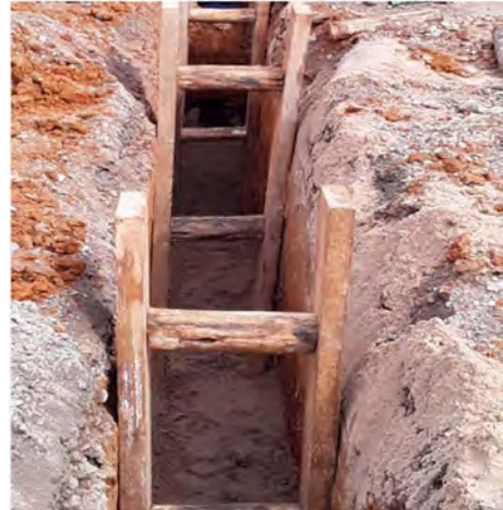
Figura 10 – Escoramento tipo Pontalete (Fonte: CAJ)
