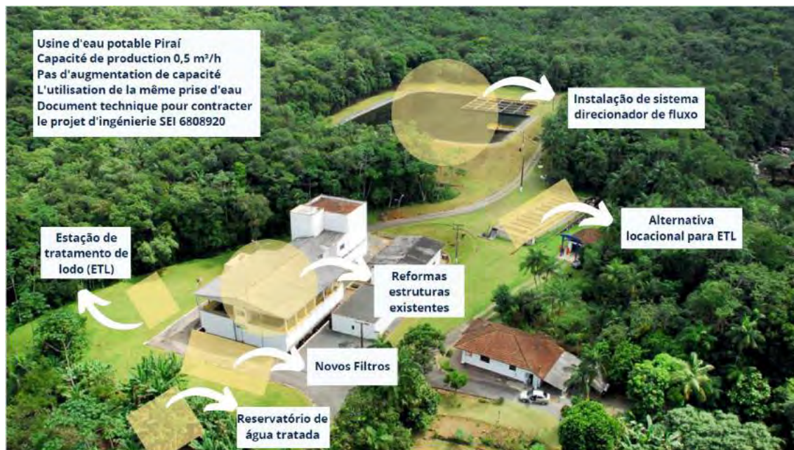
Figura 5 – Vista geral da ETA Pirai e indicativo das obras de modernização
