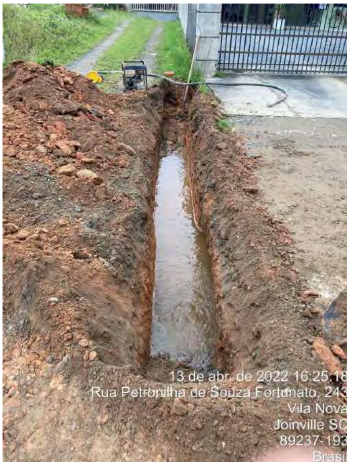
Foto 9 – Vala aberta para reforma da rede coletora
