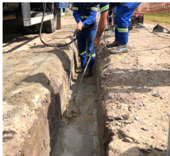
Execução do adensamento hidráulico
