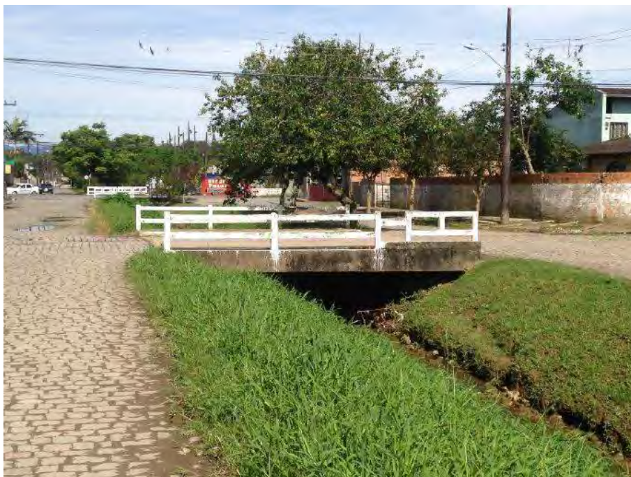
Foto 23 – Local da Travessia entre Rua dos Radialistas e Rua dos Jornalistas
