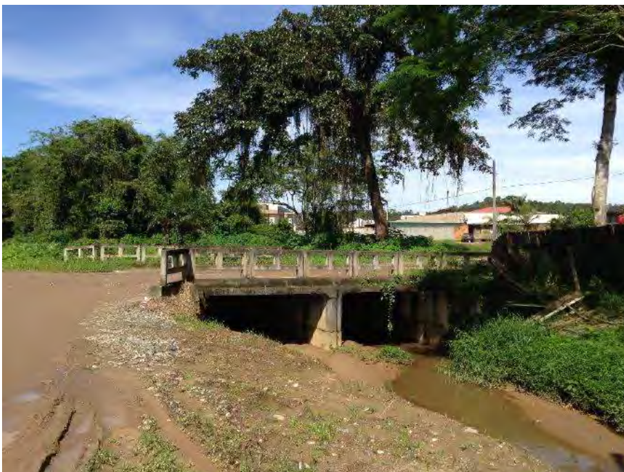
Foto 22 – Local da Travessia entre Rua dos Radialistas e Rua Petrópolis
