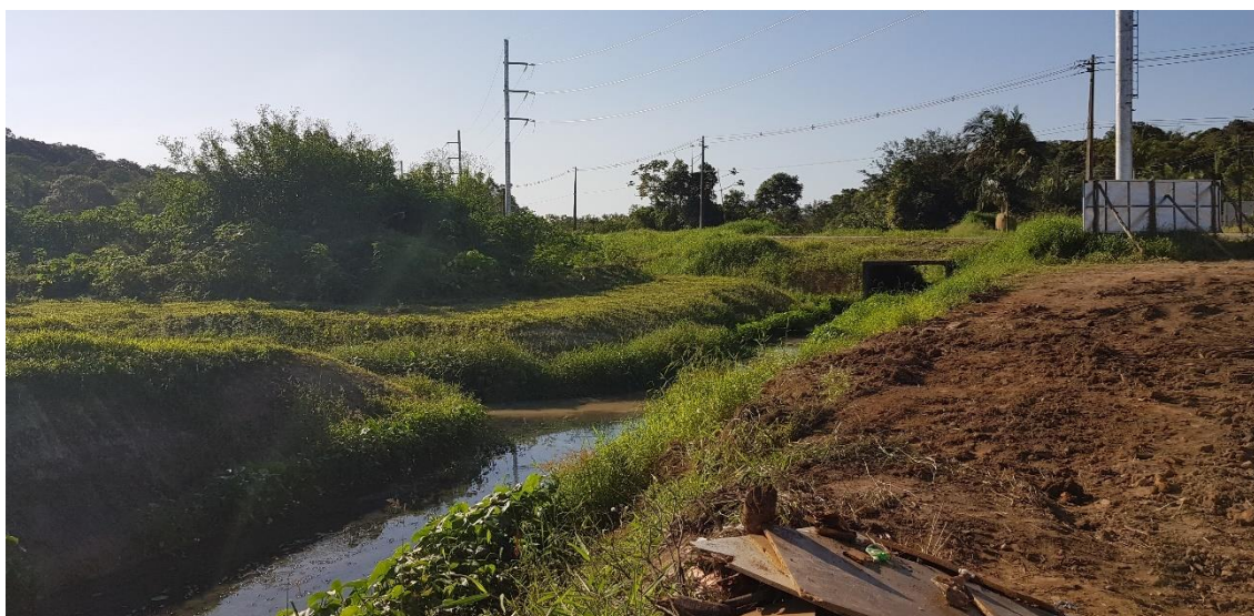
Foto 12 – Rua Renato Caetano da Silva Filho – Drenagem próxima a ETE Jarivatuba
