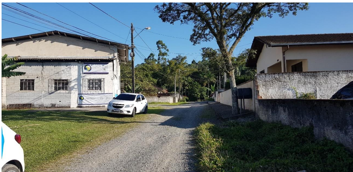
Foto 16 – Local previsto para Local Previsto para Instalação de Estação Elevatória de Esgoto – Servidão Maria Spezzia Tironi
