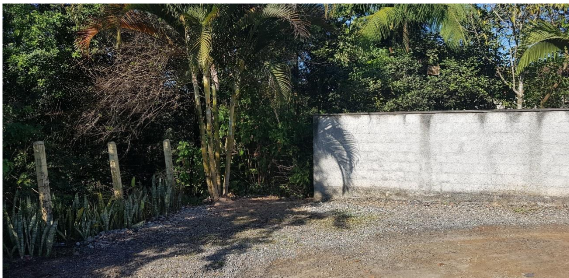
Foto 24 – Local previsto para Implantação de Estação Elevatória de Esgoto no final da rua Anêmonas
