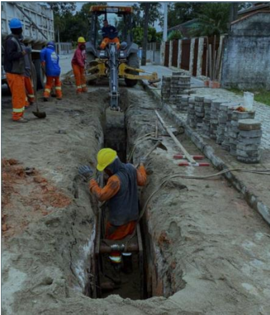
Foto 1 – Exemplo de Implantação de Rede de Esgotamento com abertura de vala
