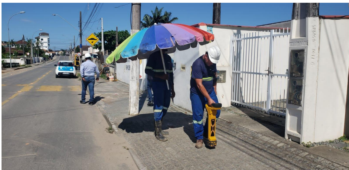
Foto 4 – Navegador na superfície monitorando a trajetória do Furo Direcional
