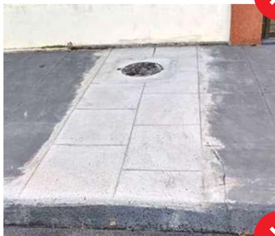
Pavimentação de concreto reprovada pelo Controle Tecnológico. O desempenho deve ser executado com uniformidade, garantindo a qualidade da calçada existente. Em casos de calçadas com desenhos no concreto ou pintura, o mesmo deve ser executado, para manter o padrão existente.
