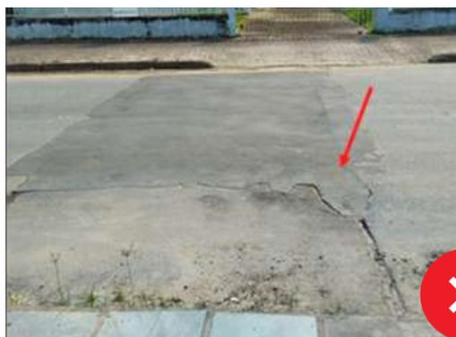
Falta de reenquadro do pavimento, todo dano causado deve ser recuperado. Para a garantia da qualidade do pavimento novo, é necessário o reenquadro das trincas que possam causar danos ao pavimento novo. Neste exemplo, temos pontos de infiltração não recuperados. São reprovadas pelo Controle Tecnológico as ondulações no pavimento e também a sobreposição de camadas asfálticas como correção (sela trinca).
