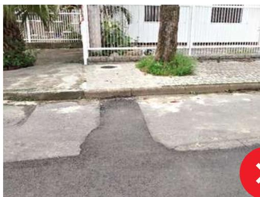
Falta de reenquadro no pavimento executado. Todo pavimento deve possuir acabamento retilíneo, sem ângulos inclinados e de preferência mantendo ângulos de 90 graus quando necessário. Neste exemplo, o asfalto deve ser cortado nas duas extremidades para o melhor acabamento. No acabamento, não ultrapassar as bordas do reenquadro para evitar o espalhamento da massa de modo irregular.
