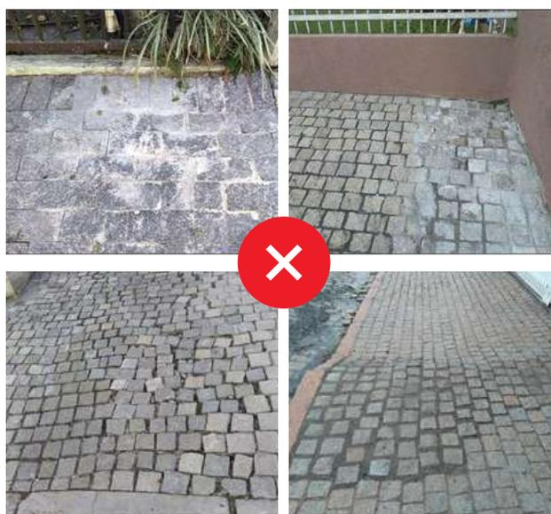
Exemplos de Pavimentação de pedras 10x10 e Miracema reprovados pelo Controle Tecnológico. As peças devem ser assentadas mantendo o alinhamento existente, devidamente travadas. A limpeza deverá ser realizada no momento da execução; excesso de argamassa nas pedras é reprovado pela CTE.
