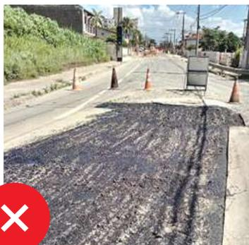
Má execução da pintura de ligação. A não execução da pintura de maneira uniforme, e em toda a superfície da base, afeta a boa aderência entre as camadas.
