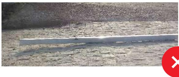
Toda pavimentação com elevação é reprovada pelo Controle Tecnológico. As peças de pedras 10x10, Miracema e granitinho devem ser assentadas mantendo a uniformidade com o pavimento existente.
