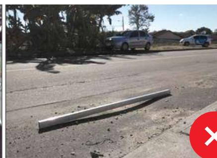
Pavimento asfáltico com recalque. Recalques com profundidade de 5 mm ou mais são reprovados pelo Controle Tecnológico. Recalques inferiores a 5 mm são analisados pela CTE; caso gere algum desconforto aos usuários, o mesmo deve ser corrigido. Nos casos em que não ocasionar desconforto, o recalque é apontado e é solicitado acompanhamento da área responsável para posterior recuperação, quando necessário.
