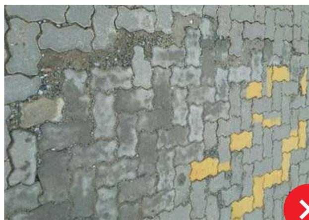
Pavimentação poliédrica com irregularidade no espaçamento, falta de travamento e pontos com falta de reposição de peça, pontos com preenchimento de concreto e peças cortadas e encaixadas de maneira inadequada. Obedecer toda a sinalização horizontal existente, repondo as peças no mesmo local. Se não for possível, deve-se substituir as peças e realizar nova pintura de sinalização horizontal. Peças trincadas e danificadas não devem ser reaproveitadas.
