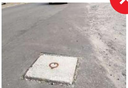
Tampas com falta de material de acabamento são reprovadas pelo Controle Tecnológico. É necessário o travamento da tampa com material adequado. A CTE solicita a remoção de todas as algas de ferro das tampas, pois podem ocasionar acidentes, e também a realização do acabamento, não deixando a ponta do ferro aparente.
