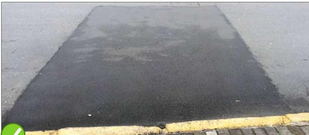
Pavimento asfáltico com compactação correta, acabamento uniforme.
