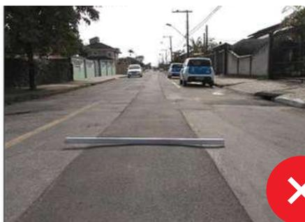
Pavimento asfáltico com elevação. Não é aceito nenhum nível de elevação no pavimento, que deve ser regularizado em conformidade com o pavimento existente.
