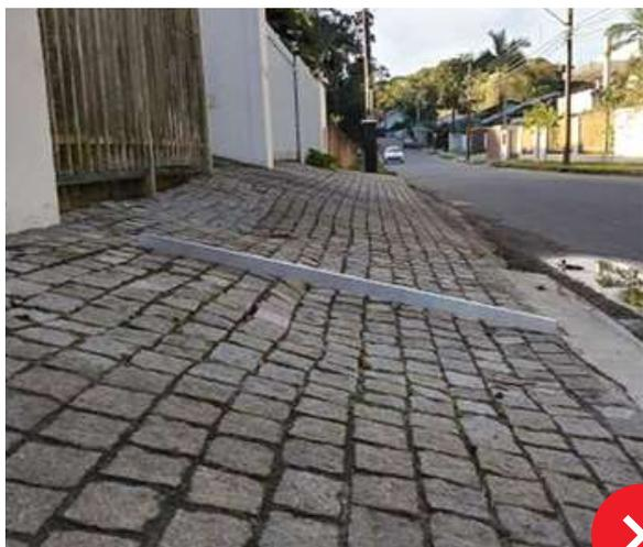
Pavimentação de pedra 10x10 com recalque. Recalques com profundidade de 5mm ou mais são reprovados pelo Controle Tecnológico. Recalques inferiores a 5mm são analisados pela CTE; caso gere algum desconforto aos usuários, o mesmo deve ser corrigido. Nos casos em que não ocasionar desconforto, o recalque é apontado e é solicitado acompanhamento da área responsável para posterior recuperação, quando necessário.
