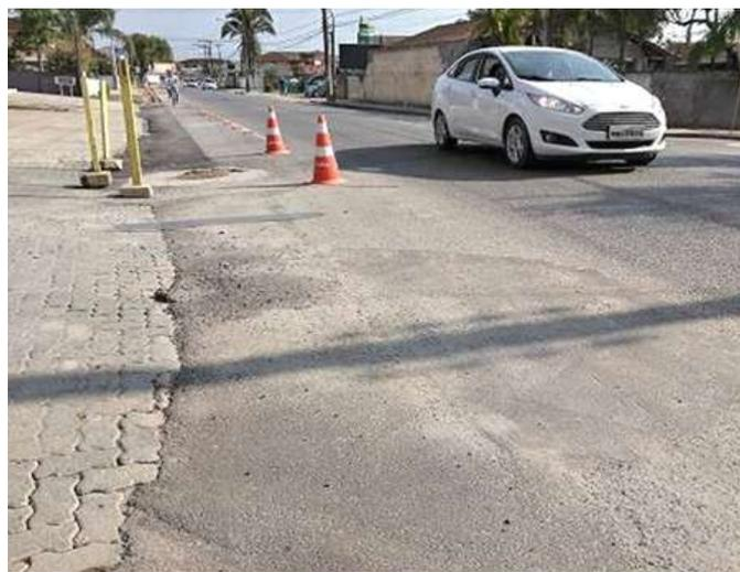
Em toda mudança do tipo de pavimento, deve ser executada uma junta de transição, para garantir o travamento e acabamento no pavimento. Neste exemplo, há falta de junta entre o pavimento asfáltico e o paver. Essa junta pode ser executada com peças de meio-fio, alinhadas ao longo do trecho.
