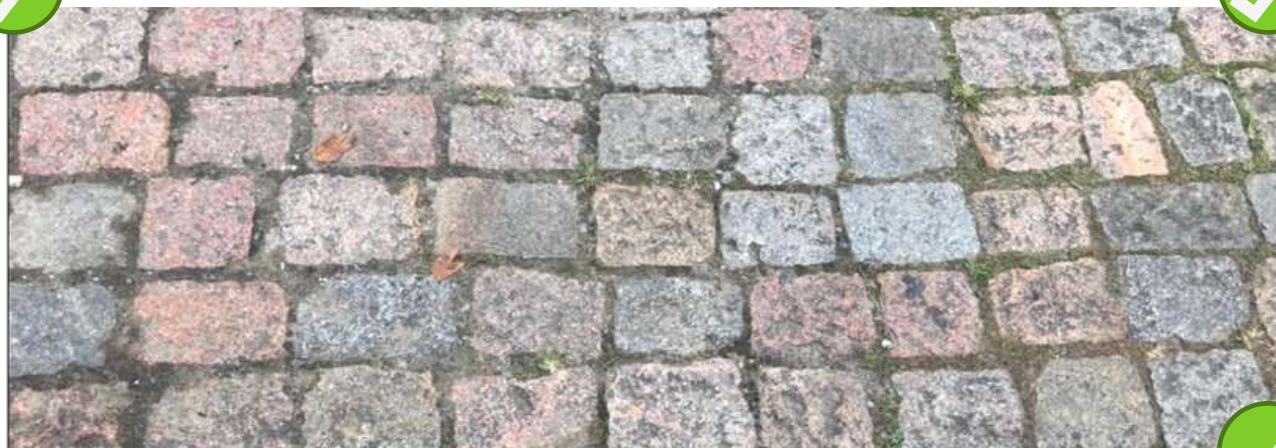
Pavimentação de lajota, paver e paralelepípedo aprovadas pelo Controle Tecnológico. Pavimentação uniforme com espaçamentos regulares, todas as peças travadas e em perfeito estado.
