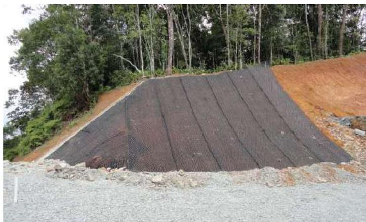
Figura 20 – Geotêxteis instaladas em talude.
