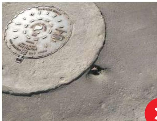
Todos os tipos de fissuras e trincas são reprovados pela CTE. No caso de erosão, é necessária a verificação da causa, correção do problema e posterior recuperação do pavimento asfáltico.
