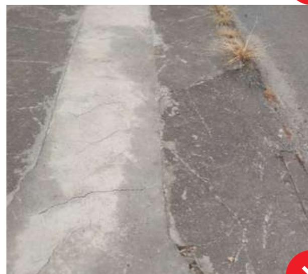
Pavimentação de concreto reprovada pelo Controle Tecnológico. Má qualidade no acabamento, desempenho, pontos com trincas não recuperados e falta de reenquadro. Na última foto, é possível verificar trincas no pavimento novo. Importante verificar frequentemente a resistência do concreto executado.
