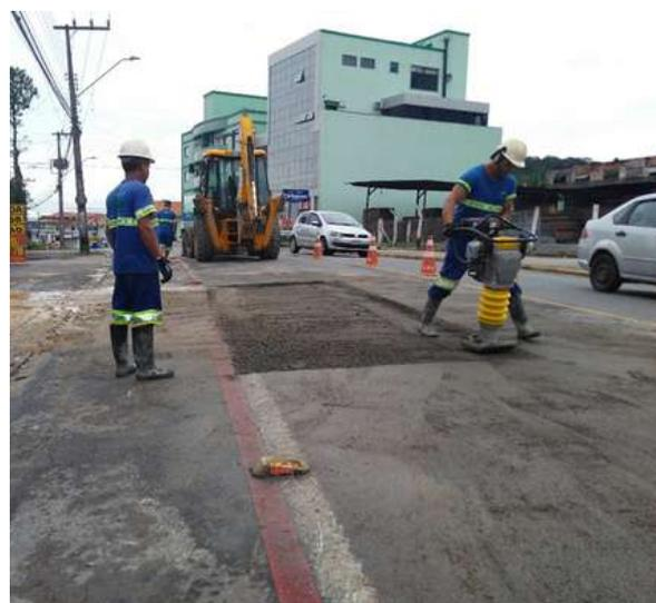
Compactação mecânica (Equipamento a Percussão Tipo Sapó)
