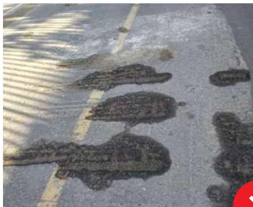
Danos ocasionados no pavimento existente pela sapata/concha da retroescavadeira devem ser corrigidos. Deve-se orientar a equipe sobre os cuidados e proteção da sapata da retroescavadeira durante a execução do serviço. Caso constatada má execução e falta de proteção, todo o dano deve ser recuperado pela empreiteira executora sem ônus para a Companhia.
