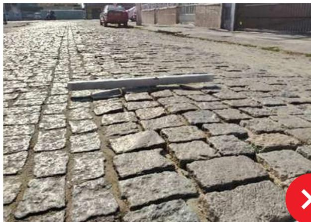
Pavimentação poliédrica com elevação e irregularidade no espaçamento, falta de travamento e pontos com falta de reposição de peça. O material utilizado para o assentamento deve ser areia fina/média isento de pedregulhos para garantir o travamento das peças.
