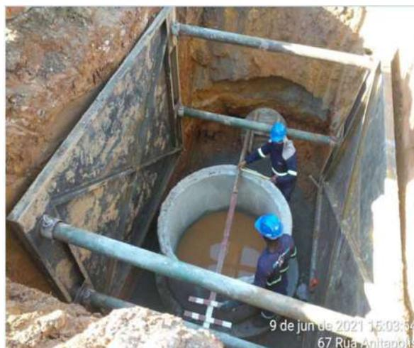
Figura 15 – Escoramento tipo Pontaleta Metálico
