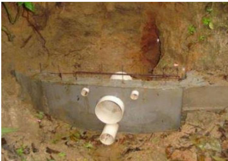
*Figura 11 - Modelo de base de proteção de nascente estilo Caxambu.*
