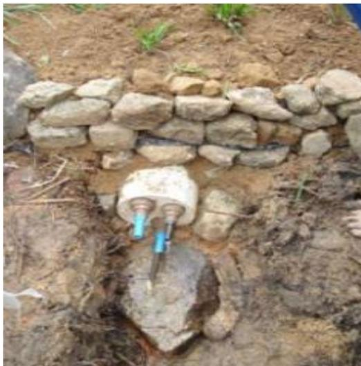
*Figura 10 - Modelo de proteção de nascentes estilo Caxambu.*
